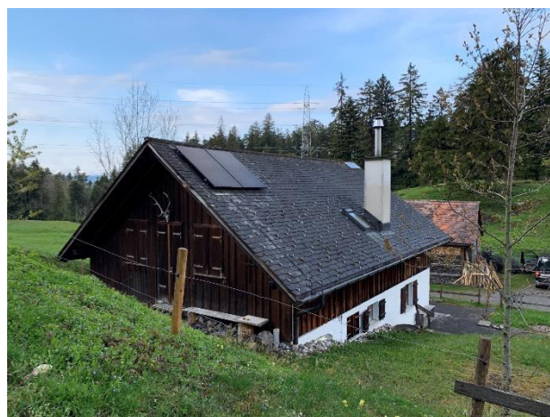
Alphütte Strüssler mit neuer Photovoltaikanlage
